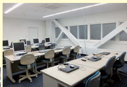
耐震補強部分
